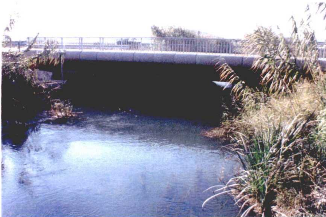
Estación de control E-21, situada sobre el puente del río Bullens que atraviesa la carretera nacional de Valencia a Alicante.
