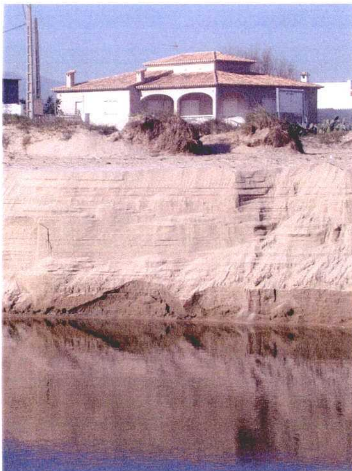
Corte transversal de la barra arenosa formada en la desembocadura del río Molinell por el temporal de mediados de noviembre de 2001. La foto está tomada días después de ser abierto el río por máquinas excavadoras
