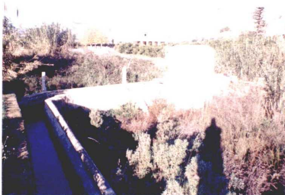
Salida de la galería del manantial de la Cava en Sanet y Negrals
