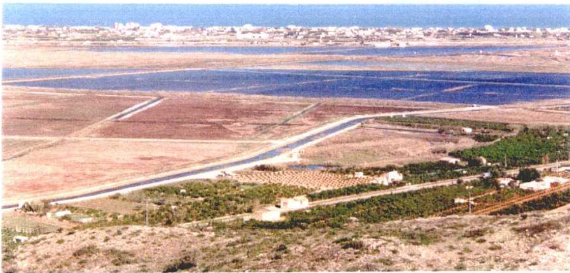
La balsa de Sineu, en el centro abajo, principal punto de drenaje del acuífero, junto al cauce modificado del río Racóns
